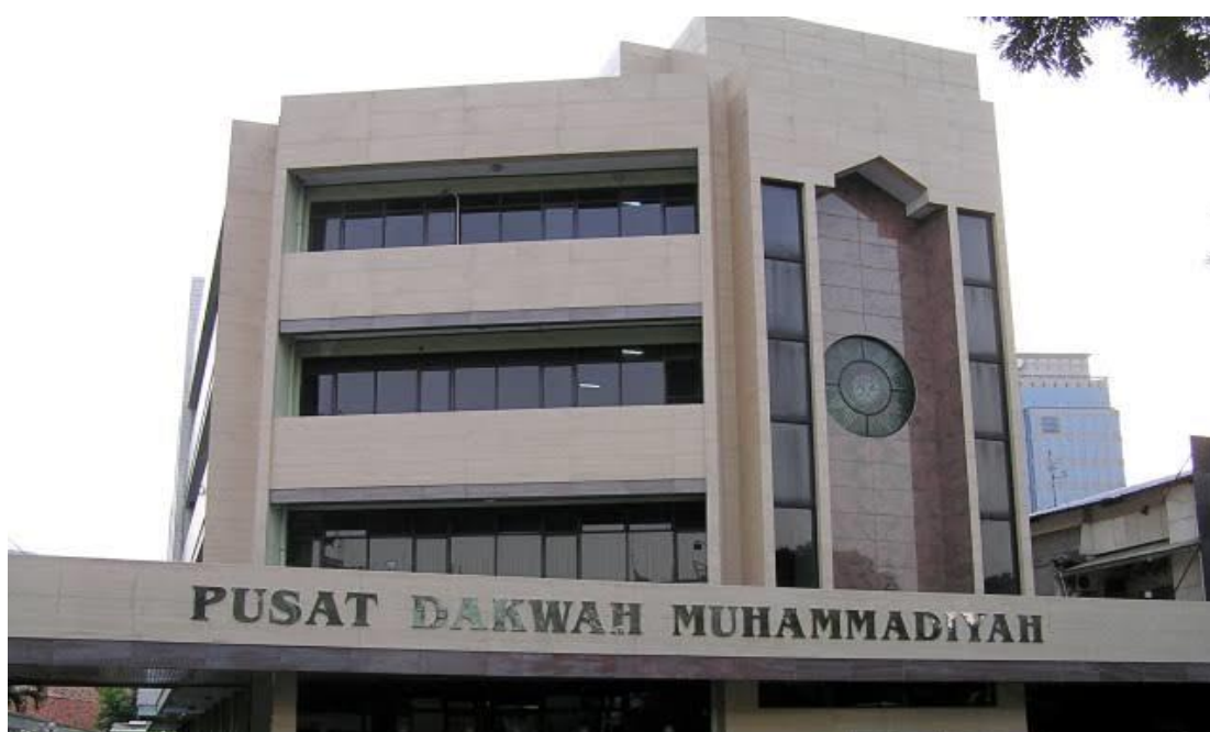
Gambar 5.6 Gedung Pusat Dakwah Muhammadiyah Sumber: Robi/ inanews.co.id (2025)
